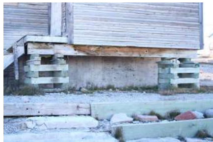
Détail des soubassements des maisons préfabriqués Igloolik, 2011
