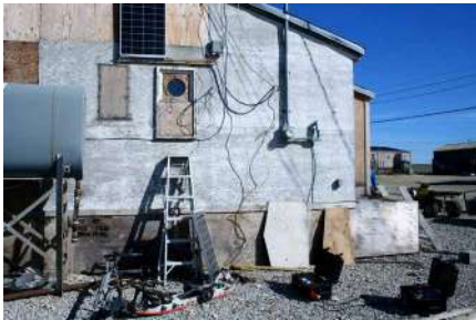
Rechargement de la "Power unit" Igloolik, 2011
