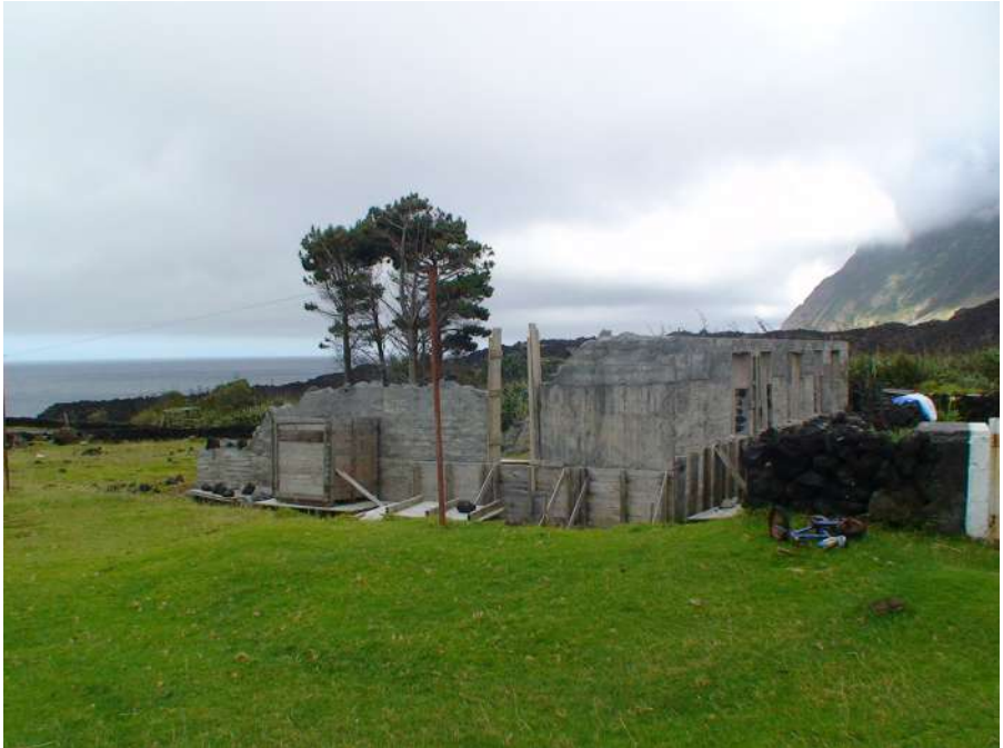
Coffrages de béton armé de lave Tristan da Cunha, 2012
